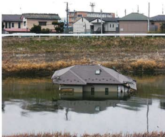
沿岸部より河川上流まで流された民家
