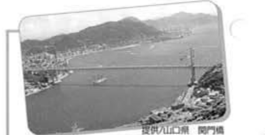
提供/山口県 関門橋
